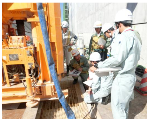
防波壁地盤改良工事点検の様子
