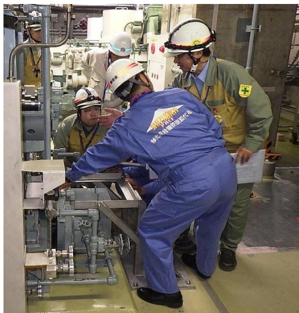
油内包機器からの漏えい拡大防止対策 点検の様子
