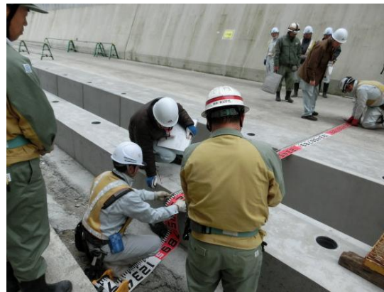
防波壁設置工事点検の様子
