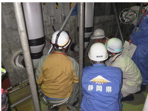
長期冷却のための代替熱交換器用配管の設置 点検の様子
