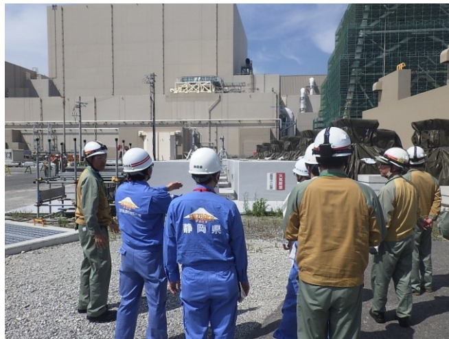
軽油タンク地下化工事 点検の様子
