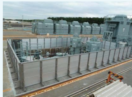
3号機海水取水ポンプエリア防水壁設置後
