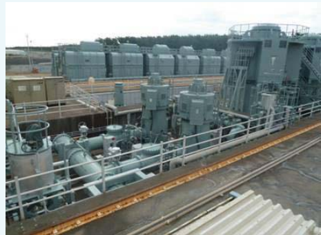
3号機海水取水ポンプエリア防水壁設置前
