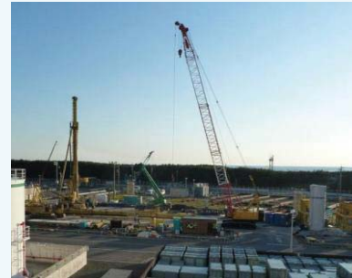
3号機 EWS 設置工事の状況
