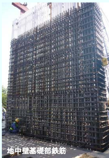
地中壁の鉄筋建て込み作業
