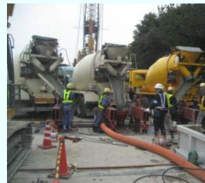
コンクリート打設作業
