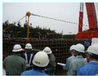
鉄筋の組み立て状況確認
