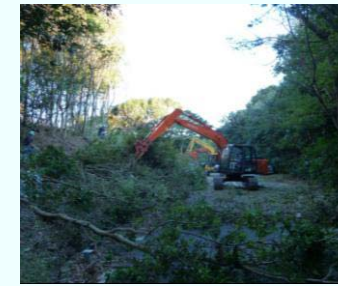
造成工事の様子
