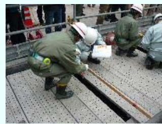
基礎部の寸法測定
