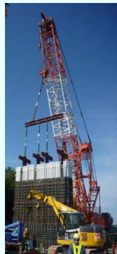
(防波壁構造イメージ) 地中壁
