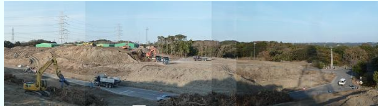
発電所敷地高台の造成工事の様子
