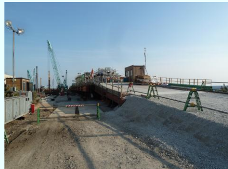
作業構台で鉄筋カゴの接続、吊り作業等をおこなっています
