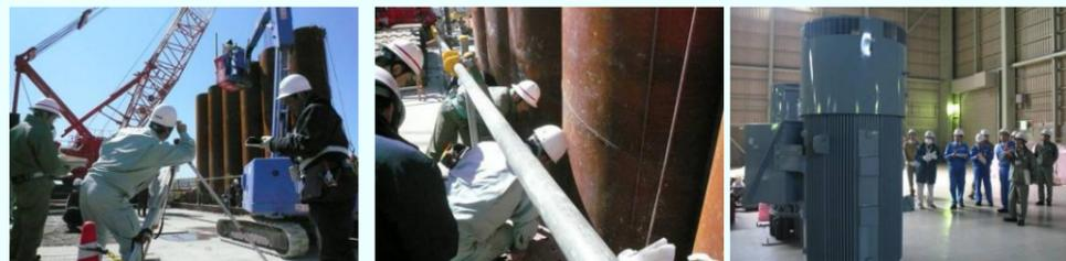
防波壁基礎部(鋼管矢板)の点検
