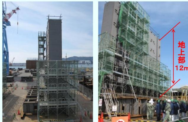
●工場内で仮組みした壁部(床版およびたて壁)の全景写真(1ブロック)
