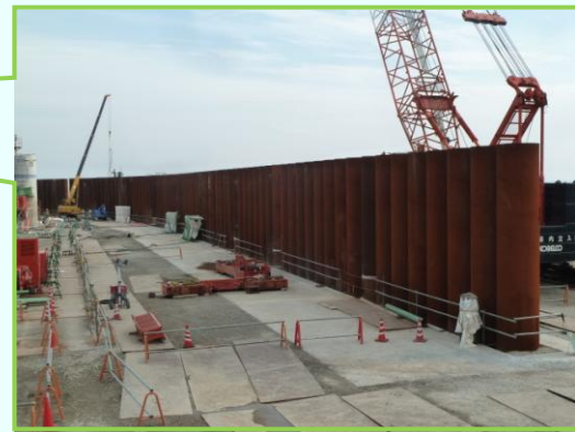
鋼管矢板の建込後の様子 今後、鉄筋コンクリート被覆の施工を行います。
