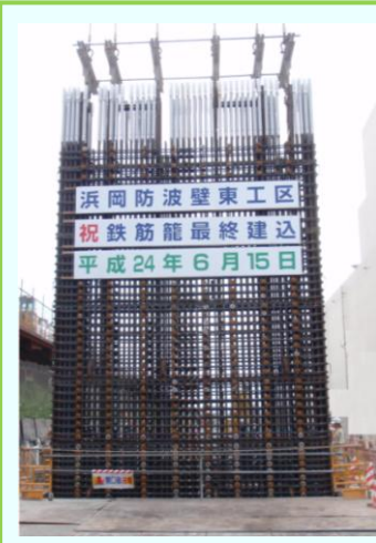
6月15日、基礎部の最終建込 翌日にコンクリート打設を実施
