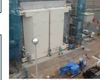
外側強化扉設置状況
