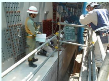
防波壁点検の様子
