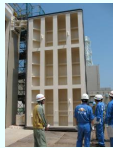
防水構造扉の信頼性強化に関する点検の様子
