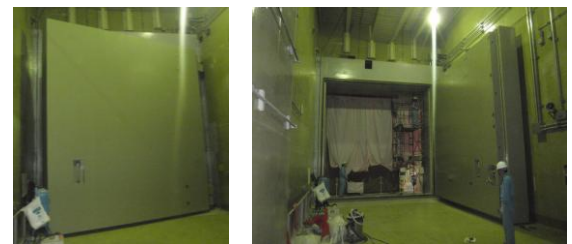
内側水密扉設置状況
