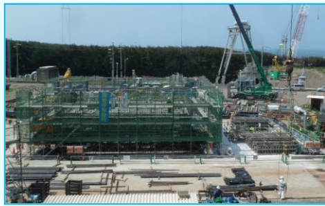
新設ポンプ室壁設置工事の様子
