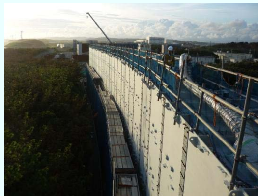
たて壁設置工事の様子(海側)
