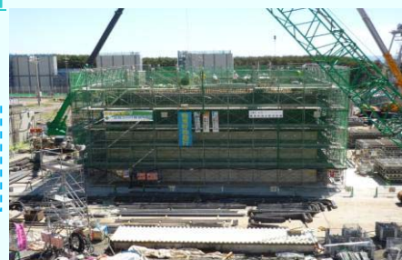
ポンプ室設置工事の様子
