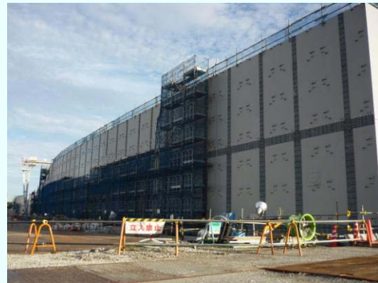
たて壁設置工事の様子(発電所敷地側)
