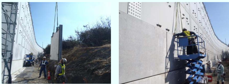
防波壁海側の壁面への防錆コンクリートパネル取付工事の様子(1月24日撮影)
