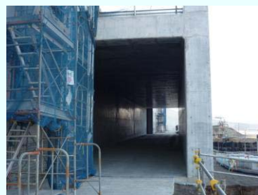
1・2号機放水路部の防波壁(箱桁構造) (2月14日撮影)
