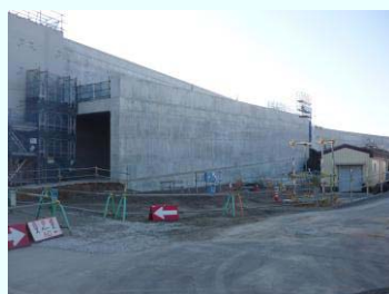
1・2号機放水路部の防波壁(箱桁構造) (2月14日撮影)
