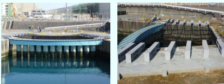
3号機取水槽へのネット設置の様子(2月28日撮影) (ネットは、主ロープ65mm・ネットロープ16mmの太さで、耐腐食性・強度等に優れた繊維ロープ仕様となっています)
