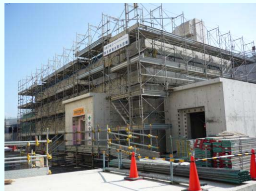
5号機緊急時海水取水設備建屋工事の様子(2月28日撮影)
