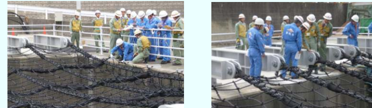
漂流物流入防止対策の点検の様子
