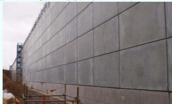
防錆パネル取付後の防波壁(海拔18m)
