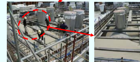
燃料タンク周りの乾燥砂充填作業の様子 7月26日撮影
