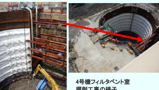
4号機フィルタベント室掘削工事の様子 7月25日撮影
