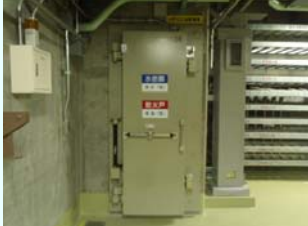
4号機原子炉建屋地下中1階に設置された水密扉 7月25日撮影
