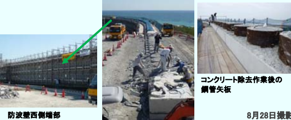
防波壁西側端部 8月28日撮影
