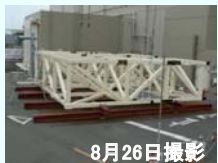
8月26日撮影 据付前のアンカーフレーム
