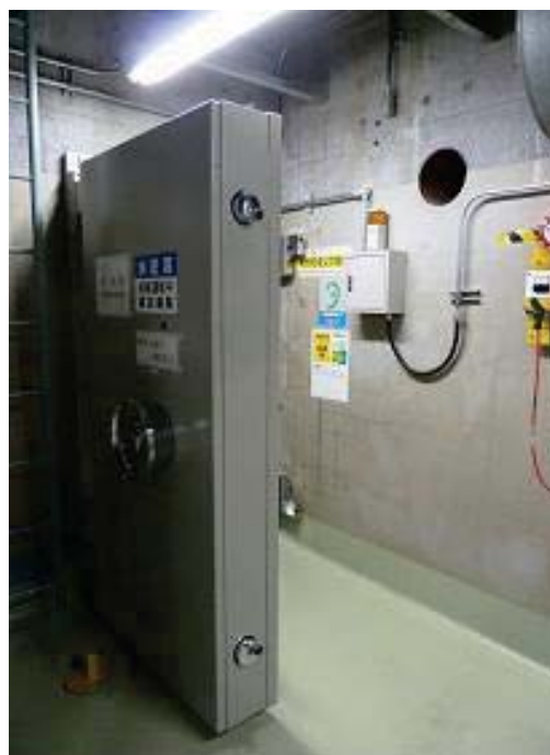
新しい水密扉を取り付けた例
