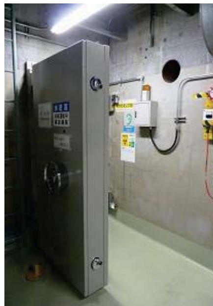
旧水密扉を撤去し、新しい水密扉を取り付けた例
