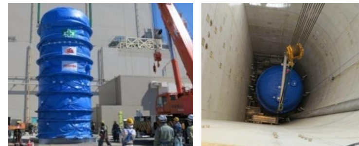
フィルタベント設備設置時の様子
