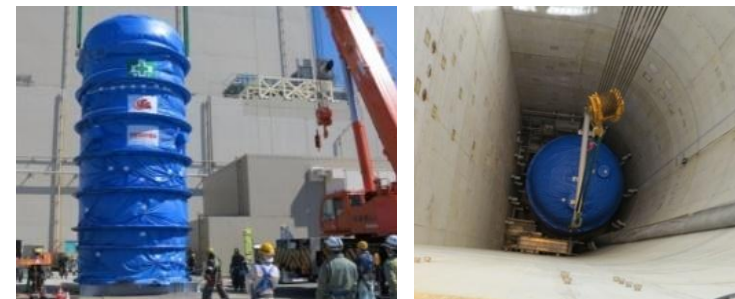
フィルタベント設備設置時の様子
