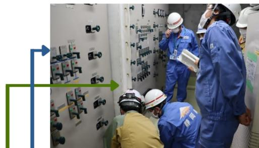
遠隔停止系盤 中央制御室外からでも原子炉を安全に停止できるように、現場に設置された操作盤。
