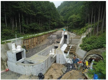
清内路水力発電所 (建設状況)
