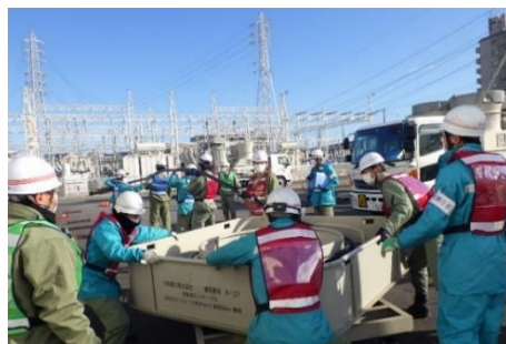
接続用ケーブルの設置作業
