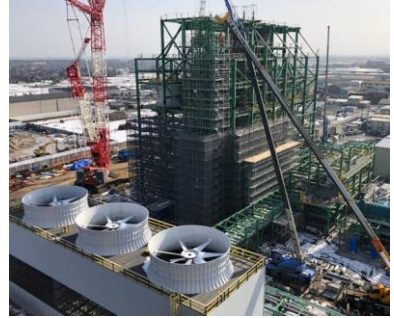
米子バイオマス発電所 (建設状況)
