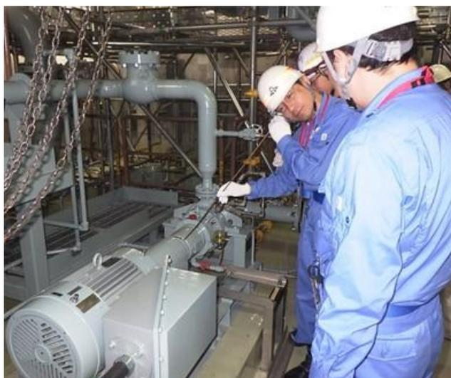
高圧注水系を運転可能とするための空冷式熱交換器の設置工事
