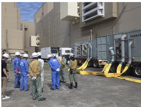
代替熱交換器用配管設置工事及び可搬設備の確保（代替熱交換器車） 点検の様子
