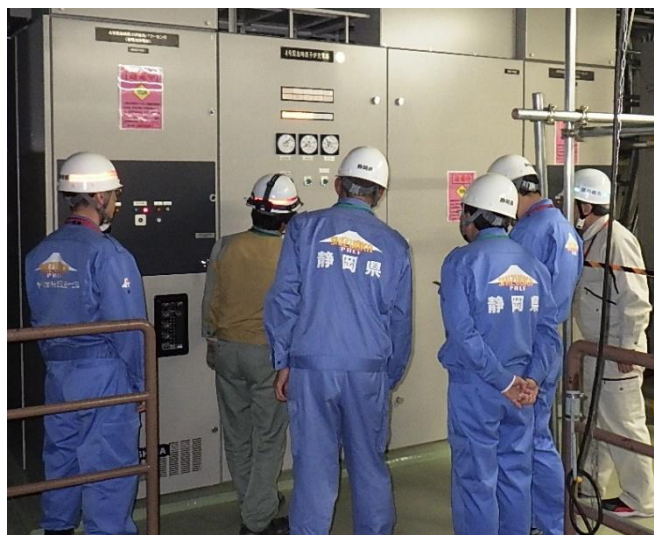
緊急時原子炉充電器現場据付状況確認の様子
