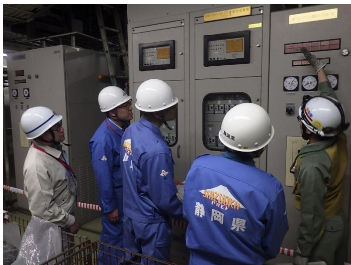
蓄電池容量の増強のうち高圧炉心スプレイ系蓄電池容量の増強工事 状況確認の様子
