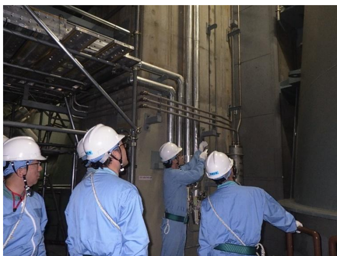
復水器水室固定サポート耐震補強工事 点検の様子
