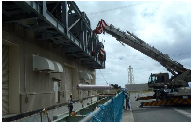
免震用オイルダンパー取替作業の様子(2020年9月2日撮影)
