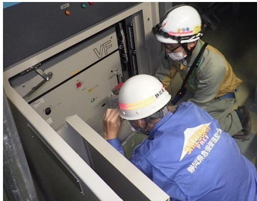
原子炉冷却材再循環ポンプトリップ機能 耐震強化工事点検の様子
