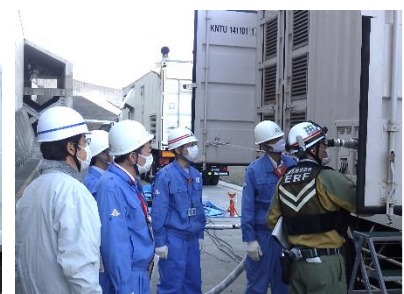
可搬型窒素ガス発生設備の 点検の様子
