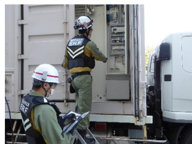
ERF による可搬型窒素ガス発生設備 の設置の様子
