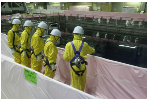
燃料プールの燃料ラック内における 使用済燃料の保管状況を確認している様子
