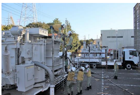
送電ケーブルの布設の様子
