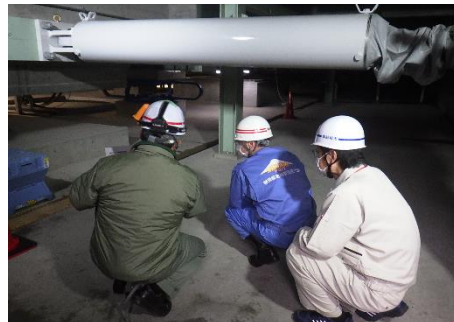
免震用オイルダンパーの点検の様子
