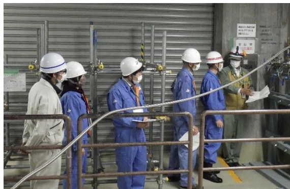
代替高圧窒素ガス供給系を点検する様子
