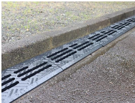
側溝用の蓋の設置
