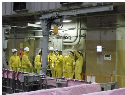
燃料プールを損傷させる可能性のある設備に施したワイヤーロープを点検している様子
