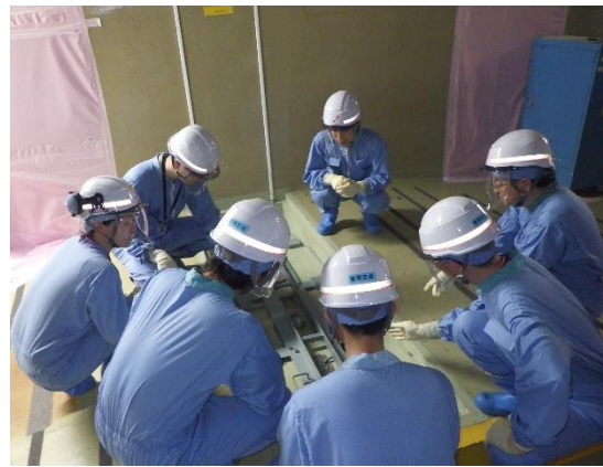
主蒸気管モニタの耐震補強を点検している様子
