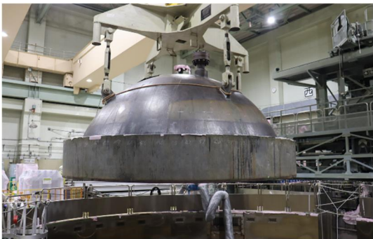
原子炉圧力容器上蓋を取り外している様子
