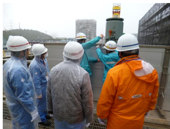
5号機海水取水ポンプエリア防水壁点検の様子
