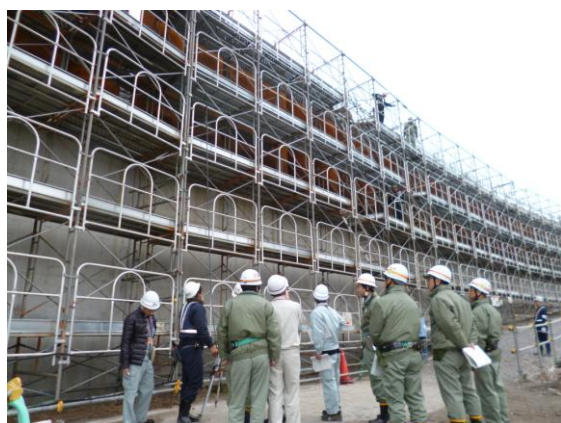
防波壁嵩上げ部点検の様子
