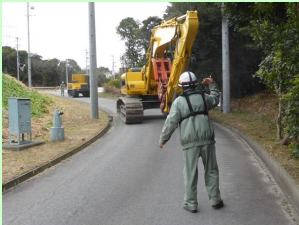
重機による アクセスルート確保の様子
