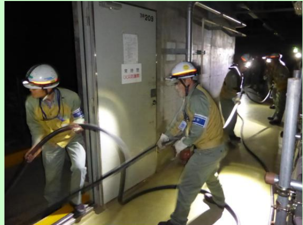
災害対策用発電機接続 (ケーブル敷設)の様子 (建屋内の照明を消して実施)
