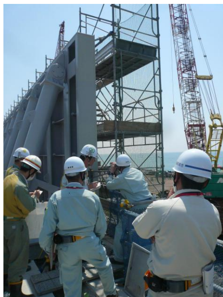
一般部壁部(継壁)点検の様子
