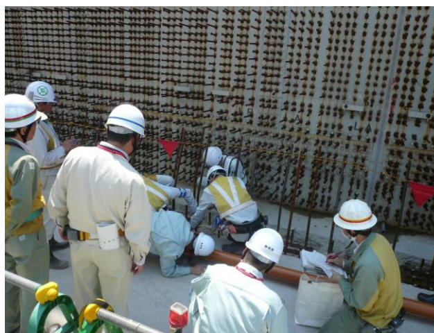
一般部たて壁下部補強部点検の様子
