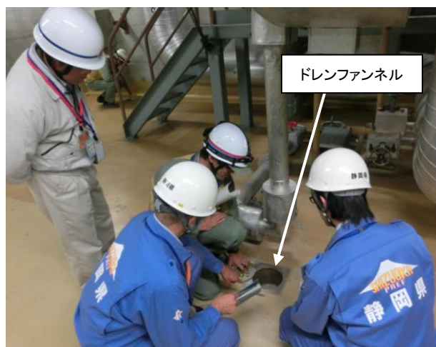
ドレンファンネルへの対策 点検の様子
