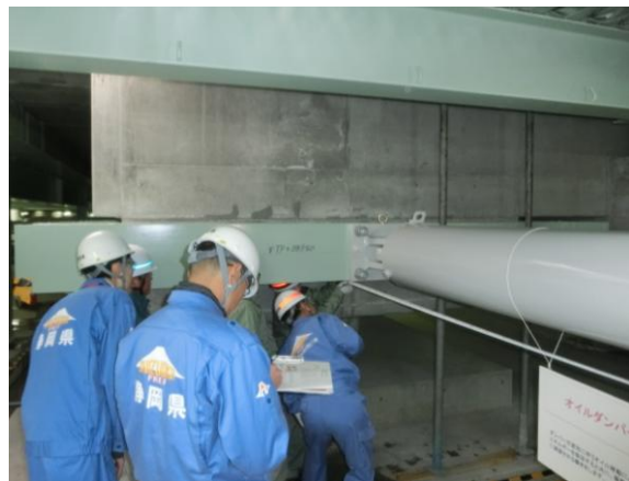
ガスタービン発電機の高台設置工事(免震装置) 点検の様子
