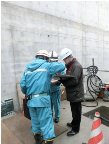
防波壁地盤改良工事 点検の様子
