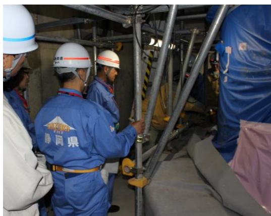
フィルタベント設備の設置工事 点検の様子
