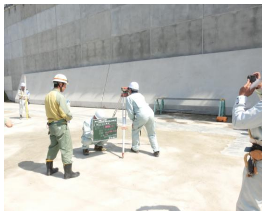
防波壁設置工事(地盤改良) 点検の様子
