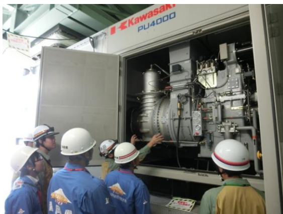
ガスタービン発電機の高台設置工事点検の様子
