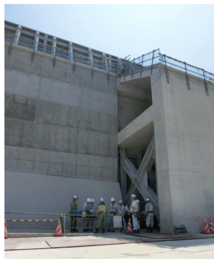
防波壁設置工事点検の様子
