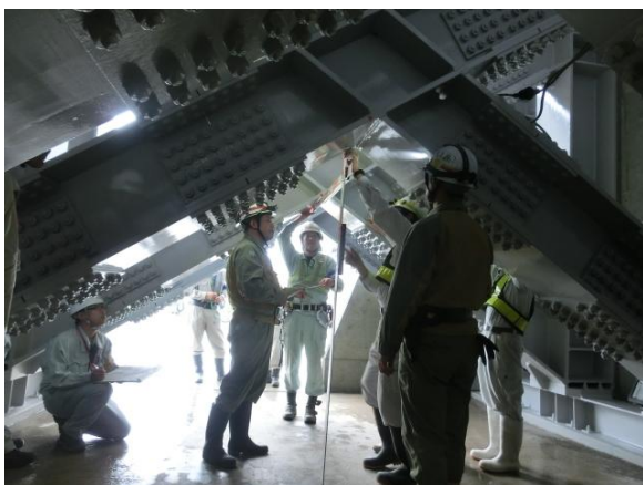
防波壁設置工事点検の様子
