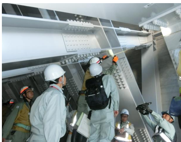
防波壁設置工事点検の様子
