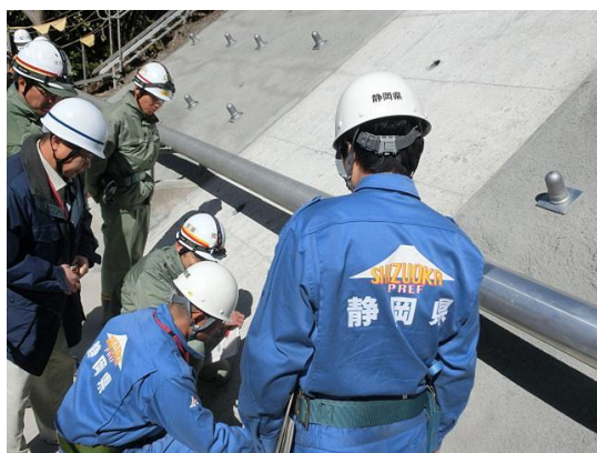
発電所敷地内の斜面補強工事点検の様子
