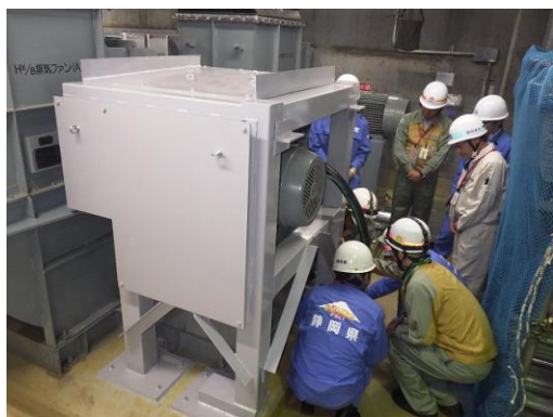
被水防護カバーの設置工事 点検の様子
