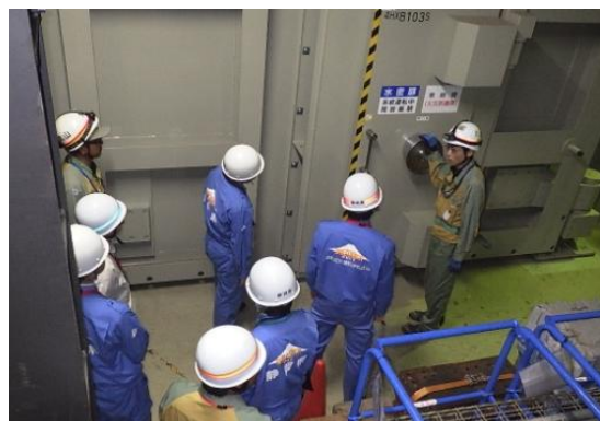
水密扉の追設・補強工事 点検の様子
